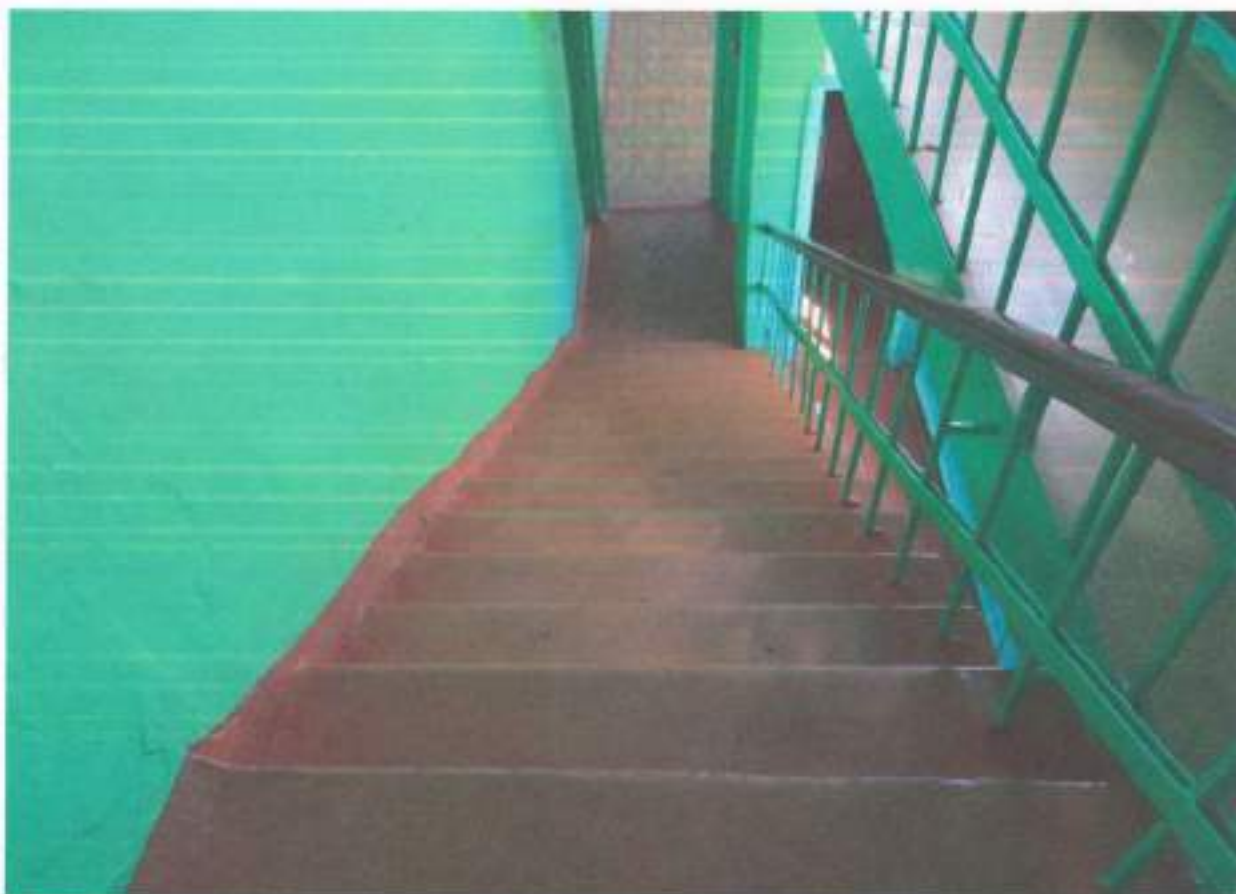
Фото 14. Лестница на цокольный этаж - столовая и туалеты (без пандуса)
